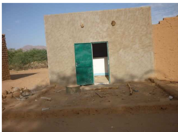
La pharmacie en cours de construction
